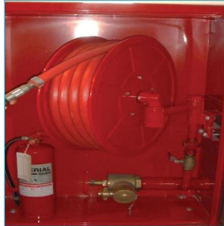
HOSE REEL ขนาด 1 นิ้ว ระยะห่างกันไม่เกิน 64 เมตร
