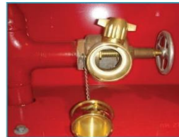
ข้อต่อสำหรับสายน้ำดับเพลิง
